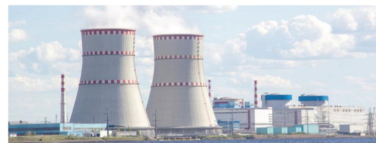
وتضم محطة الطاقة النووية ٤ وحدات طاقة بسعة ١,٢ جيجاوات لكل منها، مثبتة مع مفاعلات VVER «مفاعلات الطاقة التى يتم تبريدها بالماء»، ويتم تنفيذ بناء محطة الطاقة النووية وفقاً للاتفاقية المشتركة التى دخلت حيز التنفيذ فى ١١ ديسمبر ٢٠١٧.
